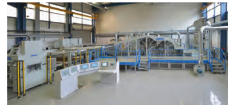
位于安德里茨阿斯兰-蒂博技术中心的针刺试验生产线
