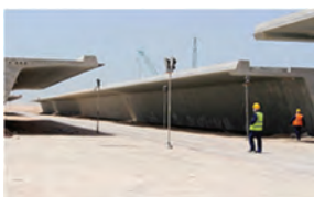
60米长，25米宽的桥跨储存在沙漠中，然后被运送到海湾
